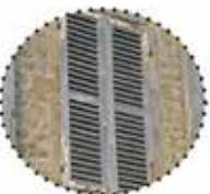
Restauration des volets existants
